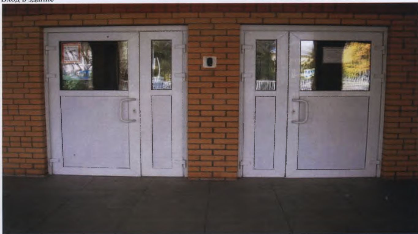
Вход в здание
